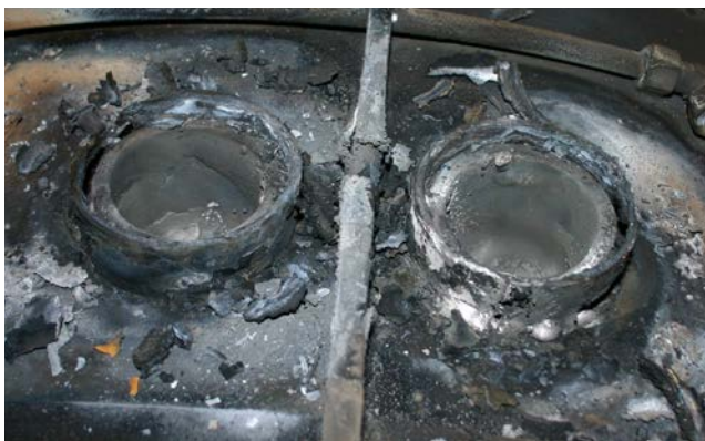
Rys. 12. Efekt zwarcia w przepustach prądowych spowodowany osadzeniem się węgla na elementach ceramicznych
