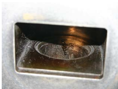
Rys. 4. Stan filtra przed systemem pompowym
